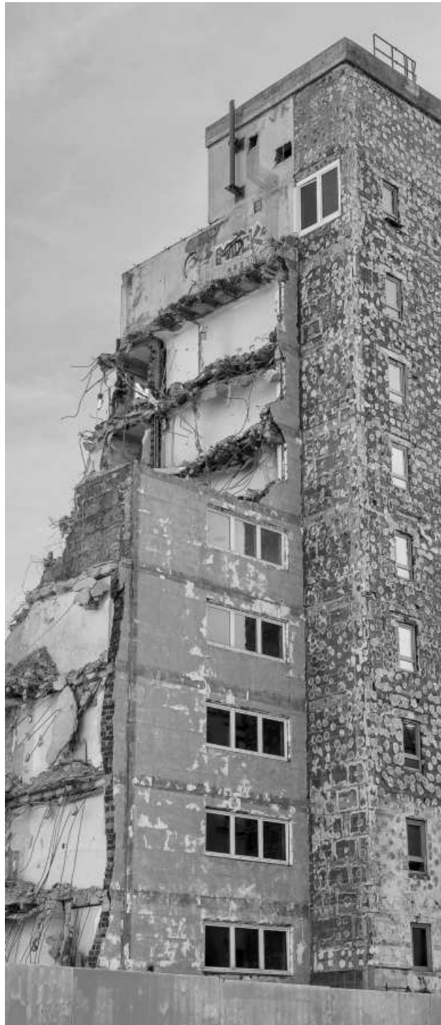
Rückbau eines Gebäudes in der Münchner Innenstadt Foto Action Press
