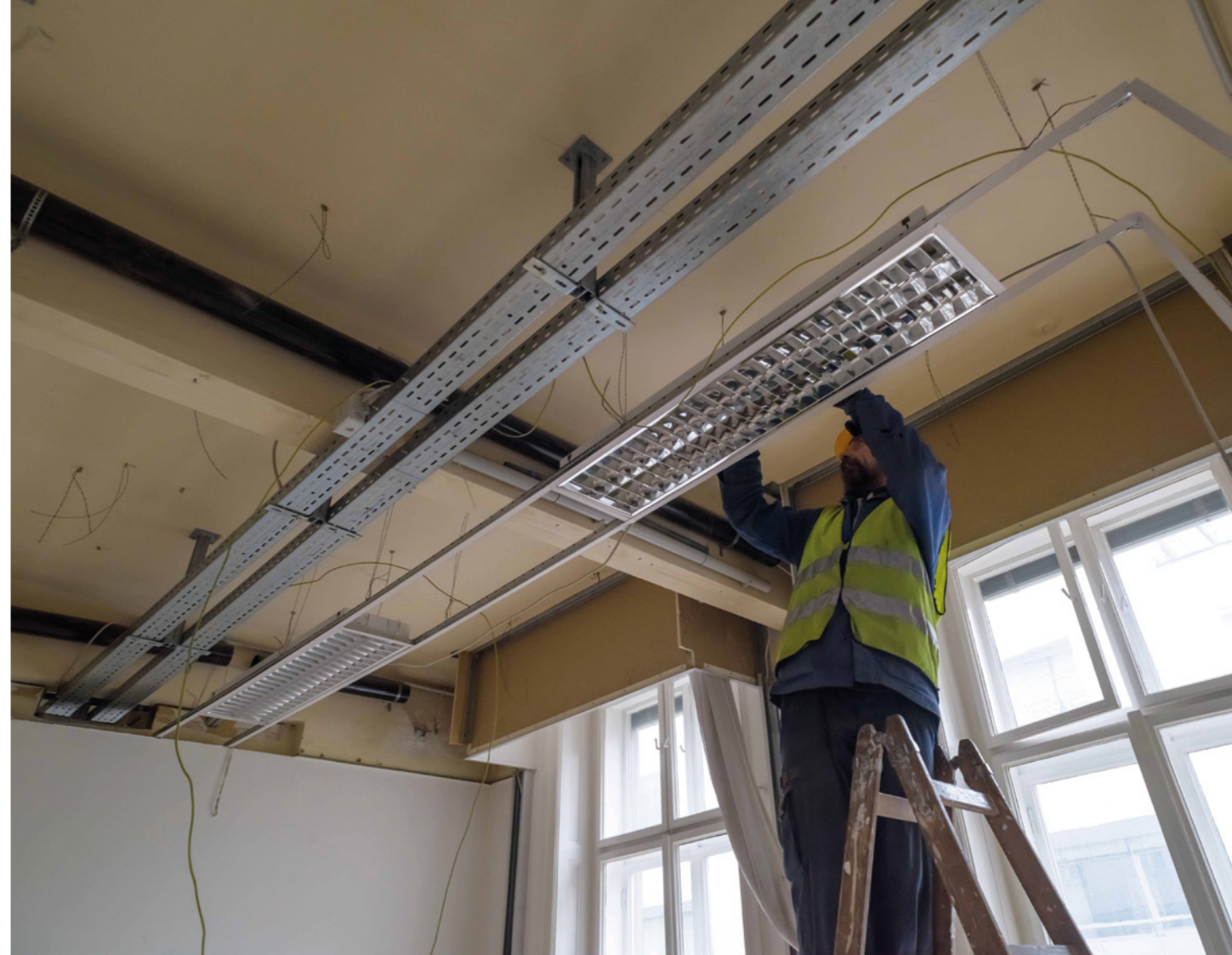
Sortenreine Material- und Bauteilentnahme im ehemaligen Wien Energie-Zentrum © Harald A. Jahn
